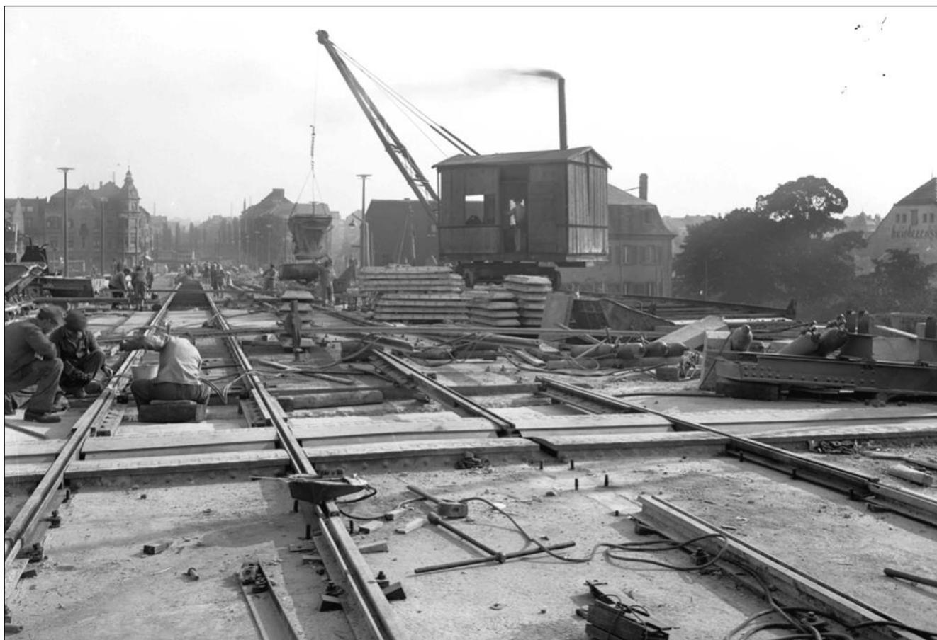
Gleisbauarbeiten auf der östlichen Brückenseite.
