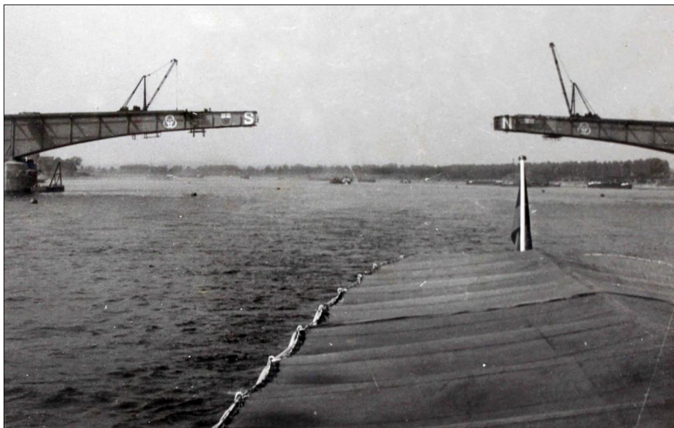
Der Bau der neuen Rheinbrücke begann zu Beginn des Jahres 1949, eröffnet wurde sie acht Monate später. Die Aufnahme entstand 1949, als der Lückenschluss des 200 Meter langen Mittelbogens bevorstand.
