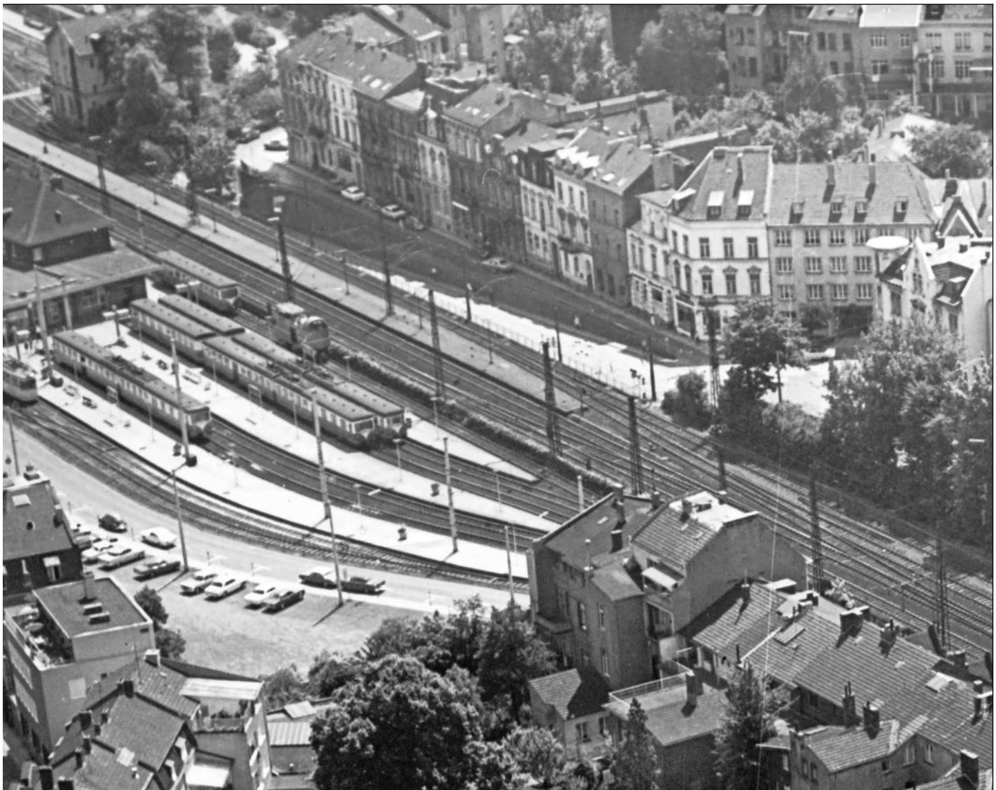
Auf um 1970 ist die Luftbildaufnahme des Rheinuferbahnhofs datiert. Gut zu erkennen sind die fünf KBE-Gleise und die beiden Gleise der BGM. An der Abfahrtstelle steht ein BGM-Zug als Linie 3 nach Mehlem-Ort. Noch steht links das Keramag-Haus mit dem ehemaligen Café Kranzler. ■ Foto: Karl-Heinz Wipperfürth, Sammlung Hans-Peter Arenz
